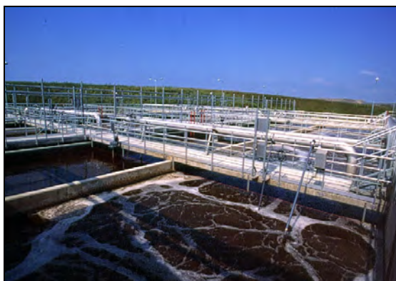
Figur 3. Sjölanda reningsverk. I förgrunden luftningsbassänger.
