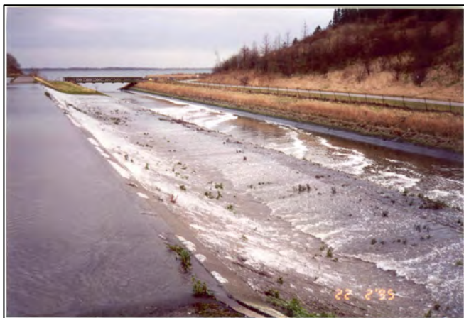
Figur 52. Overløb til Damhusåen cirka 100 meter opstrøms udløbet til Kalveboderne.
