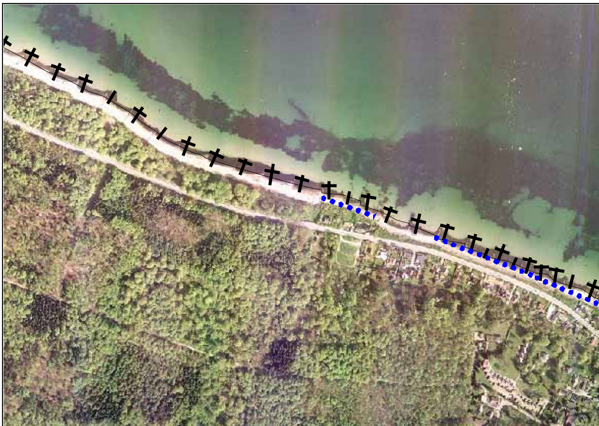
Figur 4. Område øst for Hornbæk med mange højder (sorte kors) og store sten på stranden (blå). Stenene kan være naturlige, men er ofte lagt som en del af kystsikringen.
